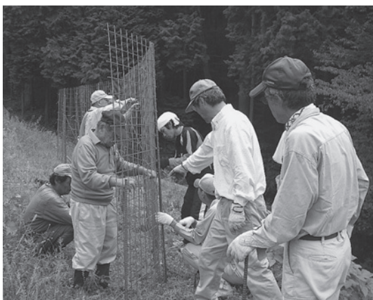
ボランティア等の連携により獣害防止柵を設置
